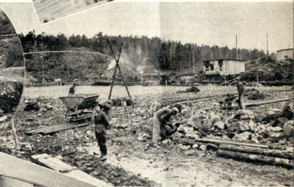
Ovan: Detalj från byggnadsplatsen.
