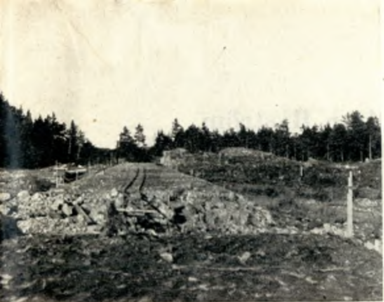
T. v.: Nya vägar byggas.
